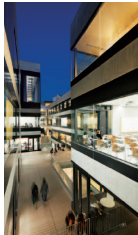
写真上 / 鉄骨の大梁、H鋼を木でくるんだ 小梁など、素材の異なるフレームが縦横 無尽に重なりあう大多喜町役場増築棟 Photo: Masao Nishikawa 写真下 / 建物が折れ曲がって寄り添うこ とで、他の授業や活動の様子が見えら れる工学院大学総合教育棟 Photo: Masao Nishikawa
