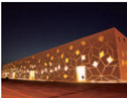
リベラル・アーツ&サイエンス・カレッジ教 養学部棟の外壁パネルのライトアップ
