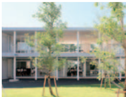
シンプルなコンクリートの「L壁」と、メーカーと 共同開発した建具からなる宇土小学校校舎
